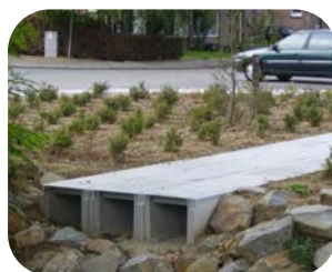
Zichtbare koppeling wadi structuren (water en dier)
